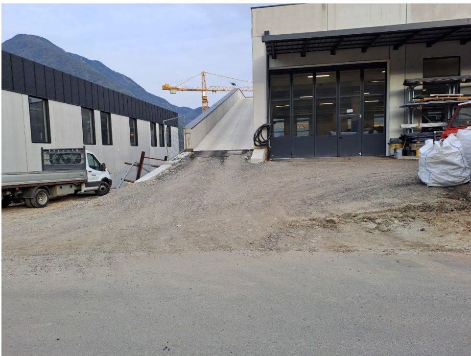
Eingang vom Parkdeck
